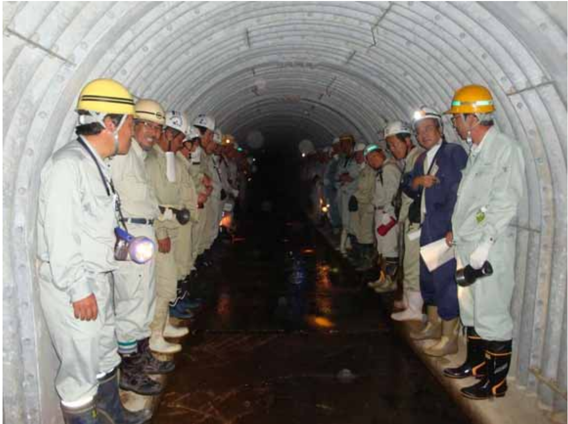
排水トンネル内にて
